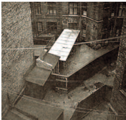
Baggården til Istedgade 117 med plankeværker og retirader, fotograferet 1970.
